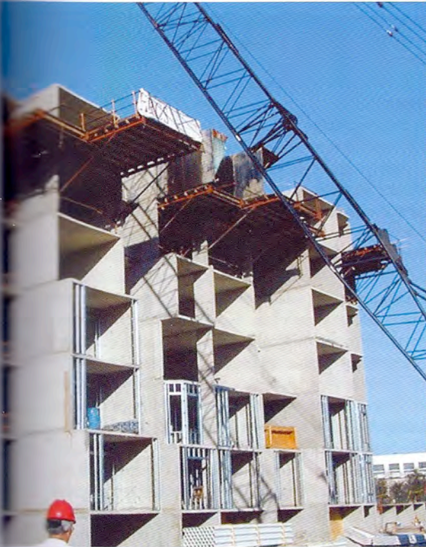
Concretos de alta resistencia inicial en la construcción de sistemas industrializados de vivienda. ARCHIVO ASOCRETO
