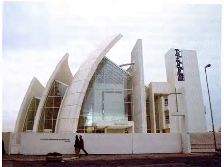
Iglesia del Jubileo en Roma. Construida en concreto blanco con un aditivo especial de dióxido de titanio, que además de preservar la blancura, es altamente reactivo cuando se expone a los rayos ultravioleta del sol. Esta reacción mata las bacterias y hongos que pueden afectar la superficie del material y además tiene la capacidad de eliminar otros contaminantes que suelen oscurecer el concreto con el tiempo. © RABEN DEWAREGA
